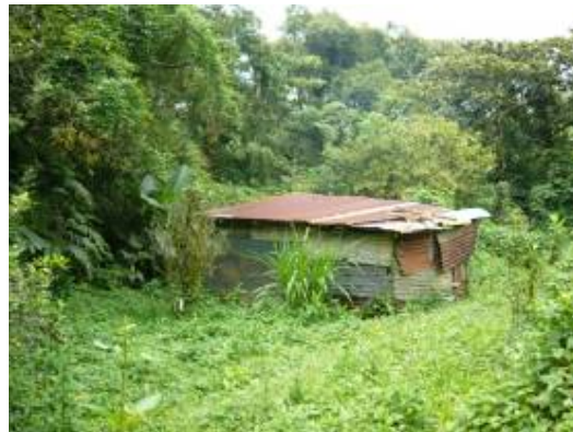
CONSTRUCCION EN EL MARGEN.
