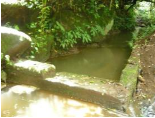
CANAL DE RIEGO.
