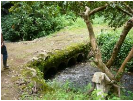
PUENTE SOBRE EL RIO.
